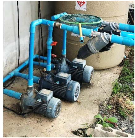
(ฐ) การติดตั้งถังและปั้มน้ำสำหรับส่งน้ำเข้ากระบะปลูก
