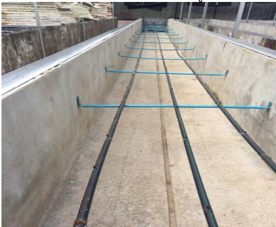
(ข) โครงสร้างกระบะปลูกแบบปูนไม่มีวัสดุรองรับ
