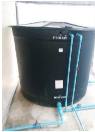
(ฐ) การติดตั้งถังและปั้มน้ำสำหรับส่งน้ำเข้ากระบะปลูก
