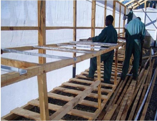
(ก) โครงสร้างกระบะปลูกแบบโครงไม้ และกรอบไม้บุด้วยแผ่นโฟม (Otazú, 2010)
