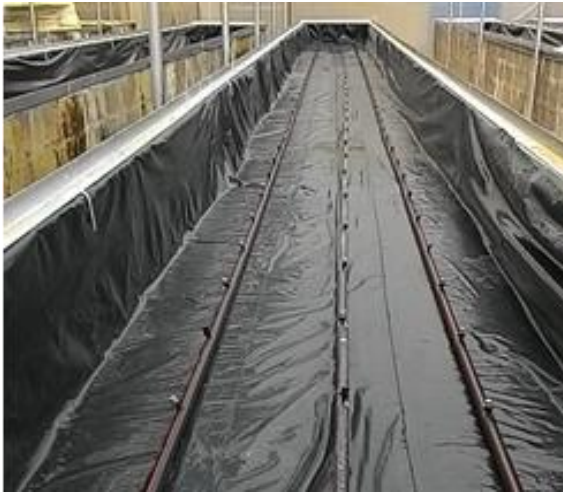
(ช) การวางท่อส่งน้ำและเจาะรูน้ำสำหรับฟันท่องฝอยภายในกระบะปลูก
