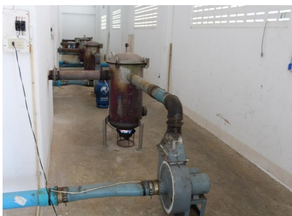
ภาพ 3.5 เตาเผาผงกำมะถันทำด้วยเหล็กปลอดสนิมหรือสแตนเลสสตีล
