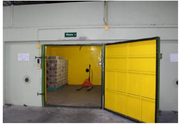
ภาพ 3.2 ลักษณะ ผนัง เพดาน พื้นห้อง และประตูทำด้วยสแตนเลสสตีลหรือเหล็ก ของห้องรม
