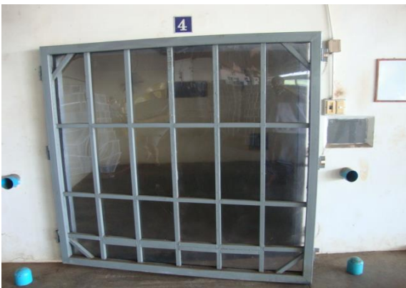
ภาพ 3.2 ลักษณะ ผนัง เพดาน พื้นห้อง และประตูทำด้วยสแตนเลสสตีลหรือเหล็ก ของห้องรม
