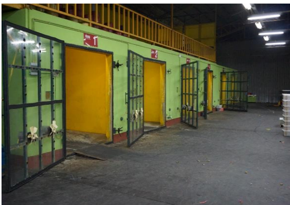
ภาพ 3.3 ประตูทำด้วยแผ่นอะคริลิกใสคล้ายกระจก
