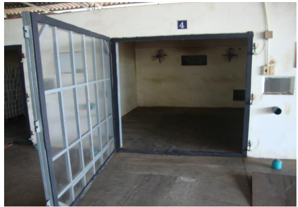
ภาพ 3.2 ลักษณะ ผนัง เพดาน พื้นห้อง และประตูทำด้วยสแตนเลสสตีลหรือเหล็ก ของห้องรม
