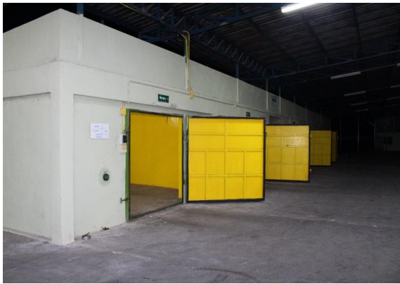
ภาพ 3.2 ลักษณะ ผนัง เพดาน พื้นห้อง และประตูทำด้วยสแตนเลสสตีลหรือเหล็ก ของห้องรม
