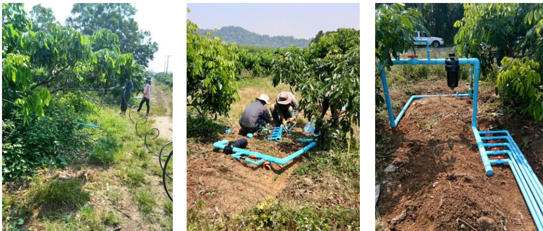
ภาพผนวกที่ 3 การติดตั้งระบบน้ำในแปลงลำไย
