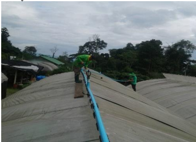
(จ) ติดตั้งระบบน้ำบนหลังคาโรงเรือน ณ ศวพ.ชม.
