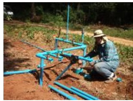
รูปที่ ๑๑. ติดตั้งระบบให้น้ำ
