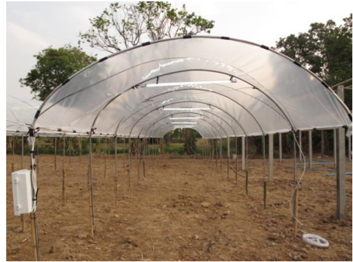
รูปที่ ๑๘ ติดตั้งหลอดไฟฟ้าใต้สันหลังคาโดยวางไขว้เสา
