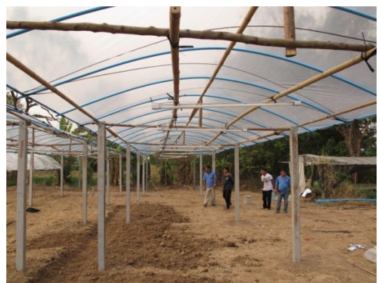
รูปที่ ๒๘ ติดตั้งหลอดไฟฟ้าได้สันหลังคา
