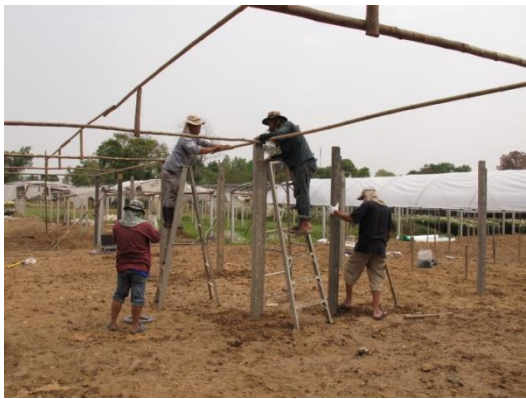
รูปที่ ๒๓ ขึ้นโครงหลังคาโรงเรือน
