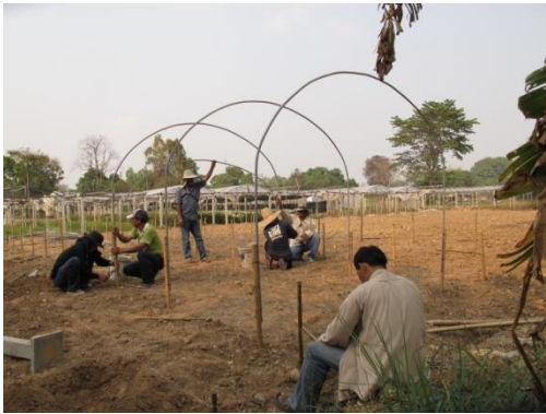
รูปที่ ๑๓ ขึ้นโครงเหล็กที่ตัดโค้งทุกระยะ ๑.๕ ม.
