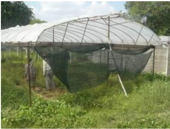
รูปที่ ๑ โรงเรือนหลังคาสูงแบบโรงเรือนเดี่ยว
