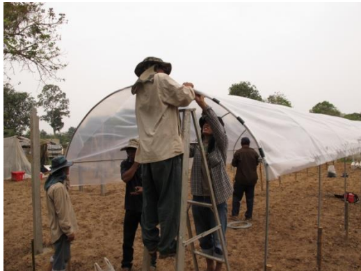
รูปที่ ๑๕ มุงหลังคาด้วยพลาสติกใสโดยยึดชายด้วยคลิป ยึดแผ่นพลาสติกโรงเรือน
