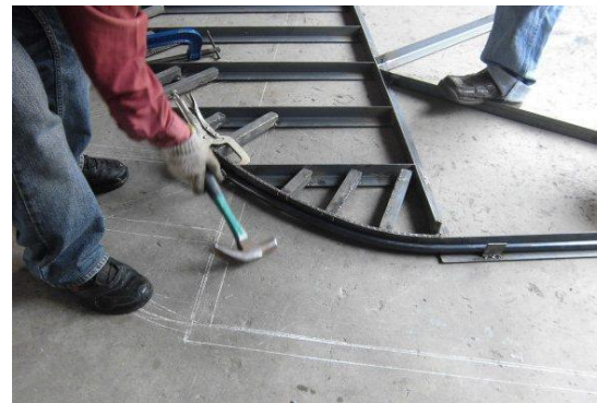
รูปที่ ๘ ใช้ค้อนเคาะให้ท่อเหล็กแนบกับแบบมากขึ้น โดยเฉพาะบริเวณส่วนโค้ง
