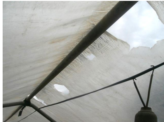
รูปที่ ๖ ปัญหาหลังคาพลาสติกขาดง่ายจากลมพัดเนื่องจากสันจั่วเป็นมุมแหลม
