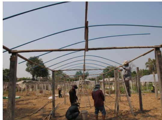
รูปที่ ๒๔ ใช้ท่อพีวีซีติดโค้งเป็นโครงหลังคา
