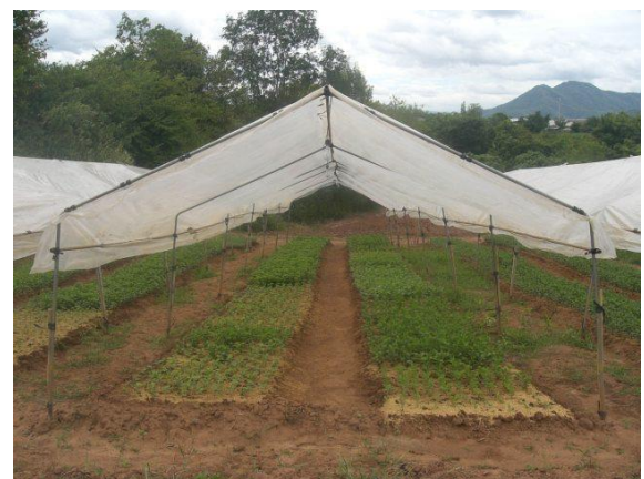
รูปที่ ๔ โรงเรือนต่ำโครงหลังคาเหล็กรูปจั่ว
