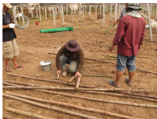
รูปที่ ๒๒ ตัดไม้ยูคาลิปตัสเพื่อทำโครงหลังคา
