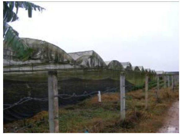
รูปที่ ๒ โรงเรือนหลังคาสูงแบบต่อเนื่อง (Multi-span)
