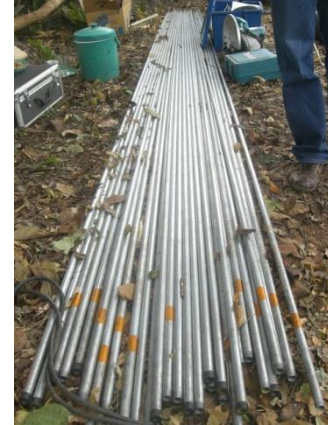
รูปที่ ๒ เตรียมท่อขนาด ๑/๒ นิ้ว ที่จะตัดโค้ง
