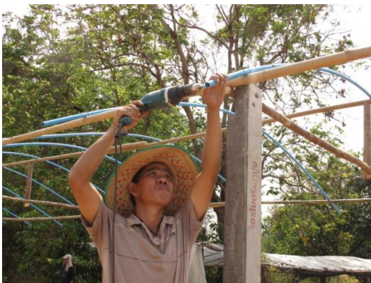
รูปที่ ๒๕ สว่านเจาะรูที่ปลายท่อพีวีซีเพื่อใช้เป็นรูร้อย ลวดยึดท่อพีวีซีที่เป็นขอบชายคา
