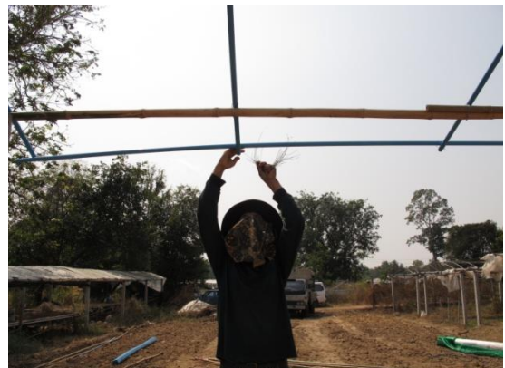
รูปที่ ๒๖ ใช้ท่อพีวีซี 1/2 นิ้ว เป็นขอบชายคาเพื่อใช้ยึด พลาสติกมุงหลังคา
