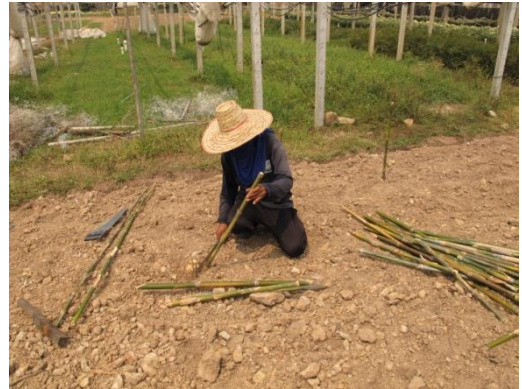
รูปที่ ๑๒ ตัดไม้รวกยาว ๑ ม. เสื่อมปลายแหลมเพื่อใช้ ตอกเป็นหลักไว้ยึดโครงเหล็ก
