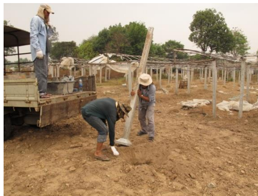
รูปที่ ๒๐ ขุดหลุมลึกประมาณ ๕๐ ซม.ลงเสาโรงเรือน
