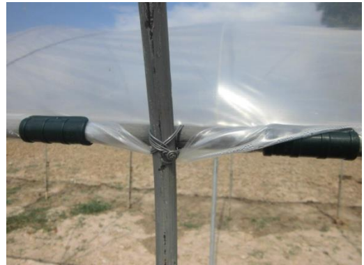
รูปที่ ๑๖ การยึดท่อเหล็กที่ขนาดตามยาวโรงเรือนกับ โครงเหล็กและการยึดชายพลาสติกด้วยคลิป
