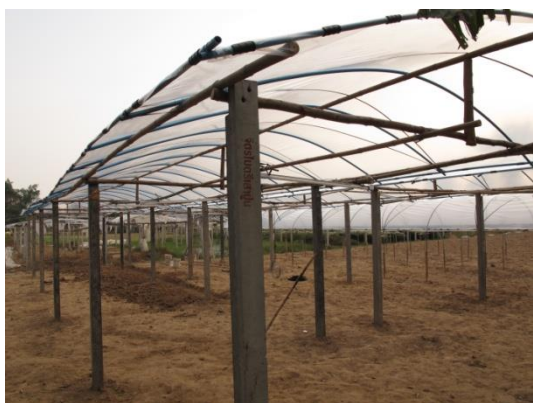
รูปที่ ๒๗ มุงพลาสติกหลังคาแล้วใช้สายรัดโรงเรือนรัด กับท่อโค้งพีวีซีโครงหลังคาโดยรัดไขว้ปลายท่อ โค้งสลับกัน
