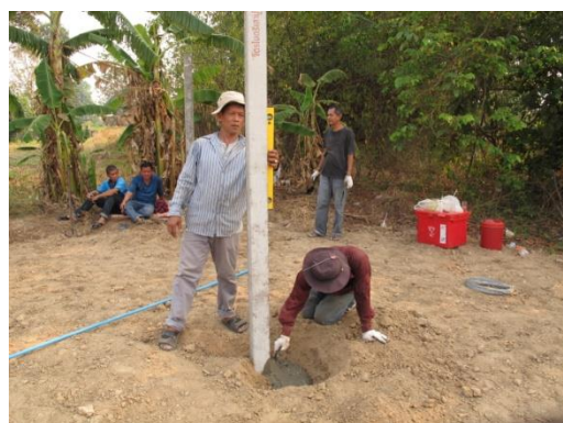
รูปที่ ๒๑ เทคอนกรีตในหลุมเพื่อยึดเสาให้แข็งแรง
