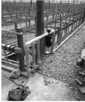
(ก) การต่อเครื่องกรองน้ำแบบเดี่ยว
