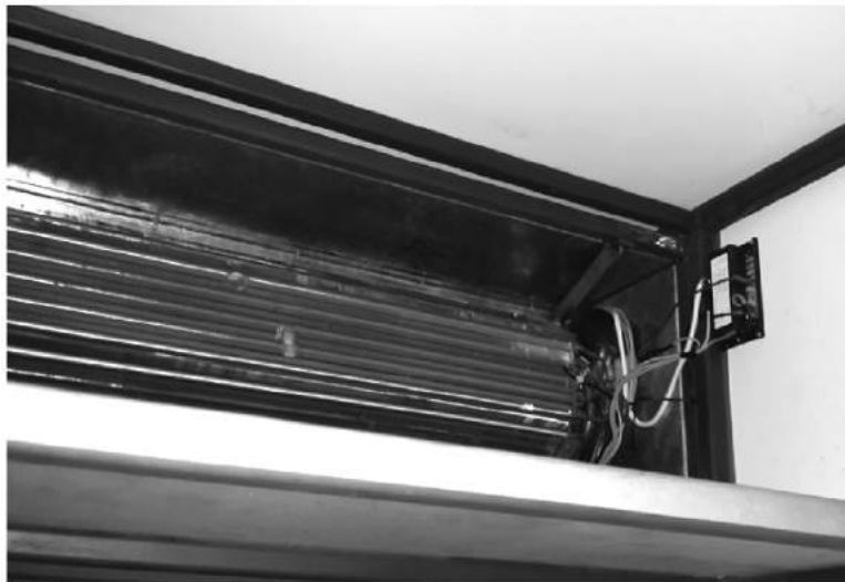
ภาพที่ 6 ติดตั้งอุปกรณ์วัดอุณหภูมิ หลังคอยล์เย็น
