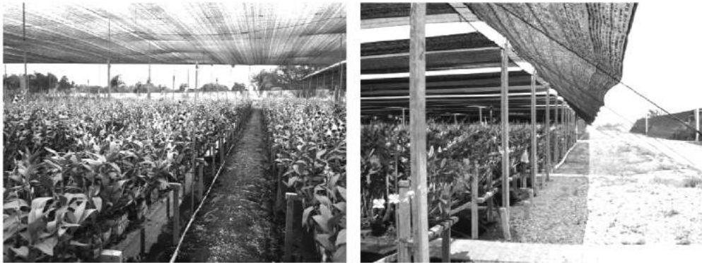
ภาพที่ 5 โรงเรือนมุงตาข่ายพรางแสงแบบหลังคาแบนและแบบยกระดับของหลังคาเพื่อระบายอากาศ
