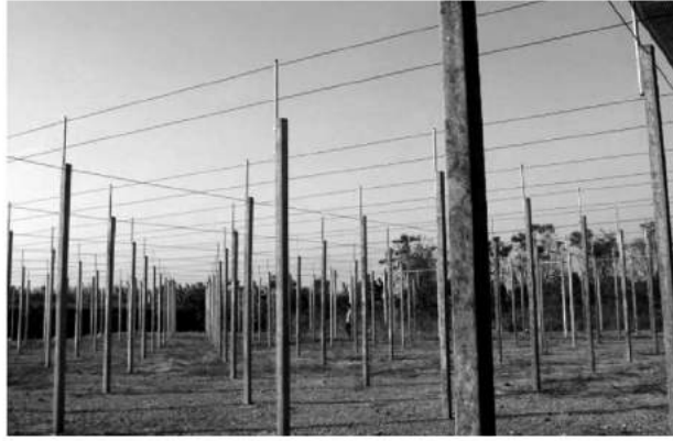
ภาพที่ 1 โรงเรือนกล้วยไม้แบบเสาคอนกรีต
